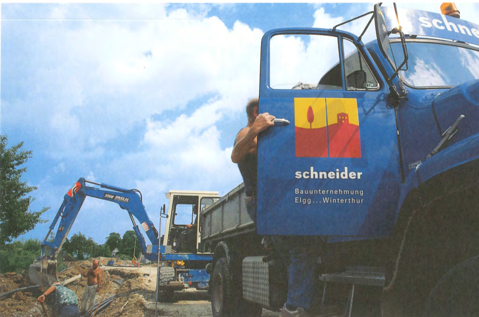
Tiefbau W. Schneider AG
