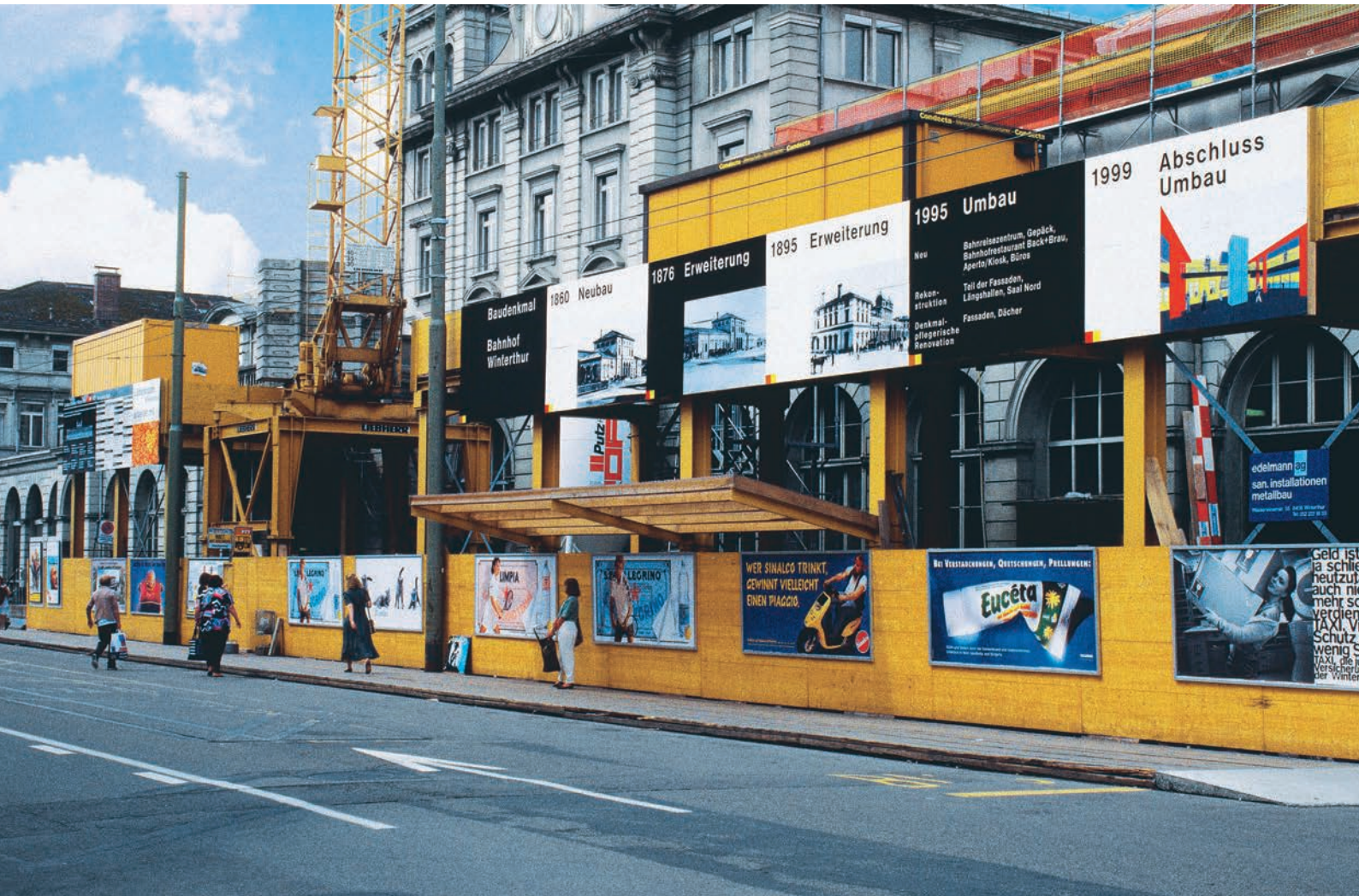
Umbau Bahnhof Winterthur
