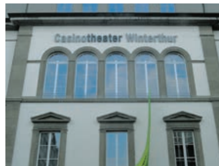
Umbau des Casinotheaters in Winterthur.
