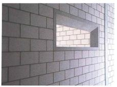
Neubau des Unterwerkes Grüze für die Stadt Winterthur. Industriebau in Stahlbeton/Stahlbau und Ausfachung der Stahlkonstruktion mit Industriesichtmauerwerk aus
